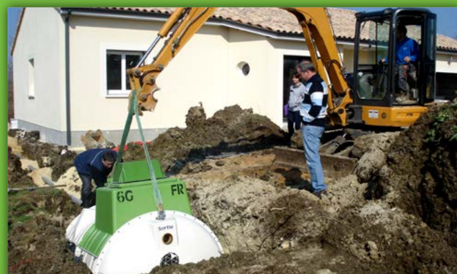
Installation d'une Tricel Novo FR6
