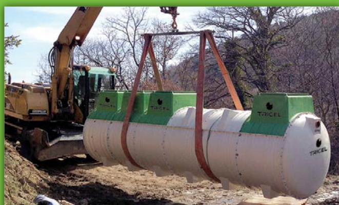
Installation d'une Tricel Novo FR20
